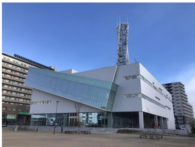
西面(杜の広場側)
